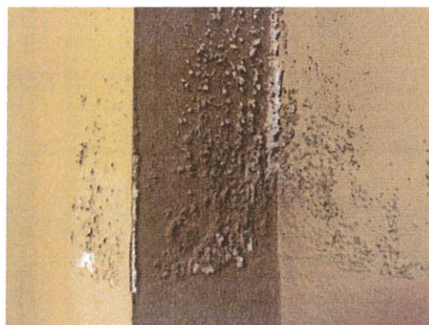
Εικ. 18. Προβλήματα αποσάθρωσης και στο επίχρισμα άνωθεν της ορθομαρμάρωσης
