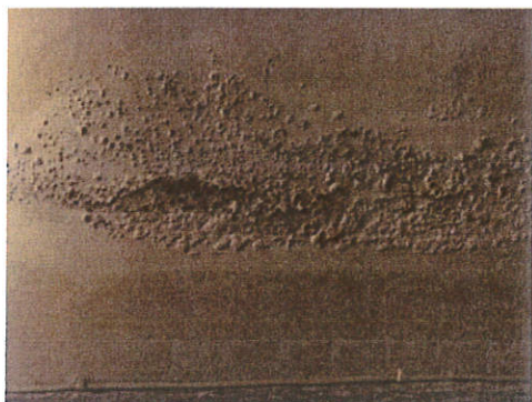
Εικ. 17. Προβλήματα αποσάθρωσης και στο επίχρισμα άνωθεν της ορθομαρμάρωσης
