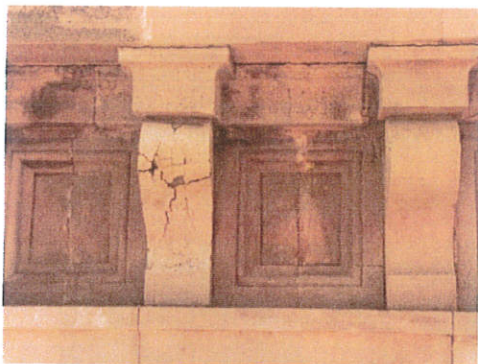
Εικ. 31. Συμπληρώσεις μελών με χυτό υλικό. Διάβρωση και θραύση της συμπλήρωσης.
