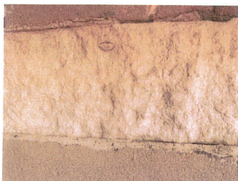
Εικ. 35. Προχωρημένη αποσάθρωση και υποχώρηση της επιφάνειας
