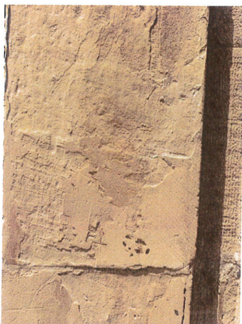
Εικ. 33. Αποφλοιώση και απώλεια υλικού
