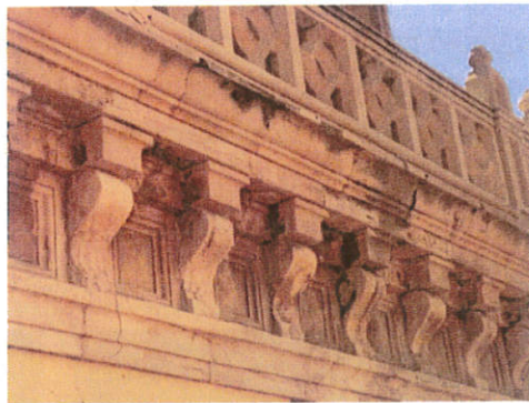
Εικ. 30. Αποσάθρωση λίθων και συμπληρώσεις με κονιάματα.
