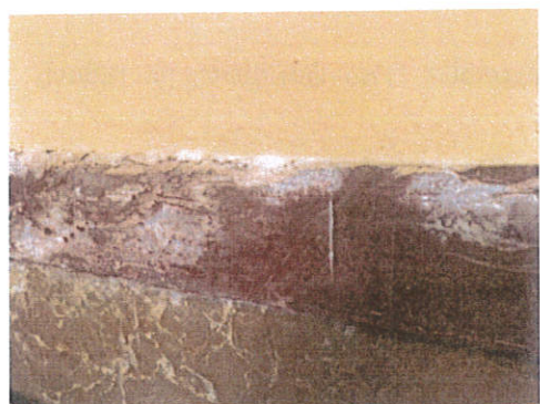
Εικ. 13. Εξανθήσεις διαλυτών αλάτων και επιφανειακή αποσάθρωση του κόκκινου λίθου.
