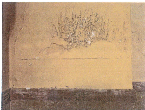
Εικ. 19. Προβλήματα αποσάθρωσης και στο επίχρισμα άνωθεν της ορθομαρμάρωσης
