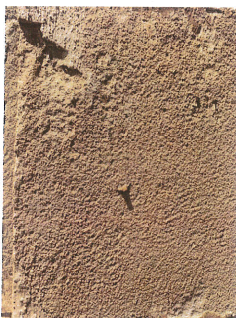
Εικ. 34. Επιφανειακή αποσάθρωση λιθοσώματος
