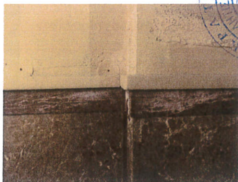
Εικ. 16. Προβλήματα αποσάθρωσης και στο επίχρισμα άνωθεν της ορθομαρμάρωσης
