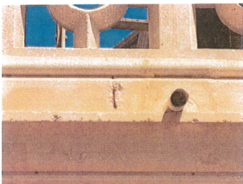
Εικ. 29. Στηθαίο. Συμπληρώσεις μελών με χυτό υλικό. Διακρίνεται ο οξειδωμένος οπλισμός.
