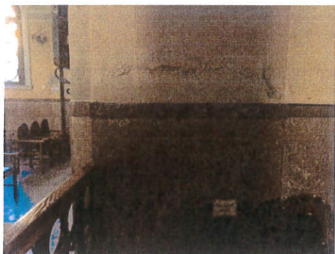
Εικ. 15. Προβλήματα αποσάθρωσης και στο επίχρισμα άνωθεν της ορθομαρμάρωσης
