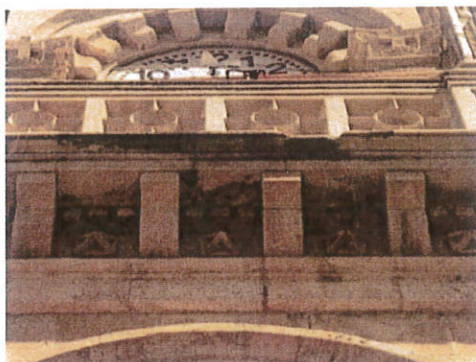
Εικ. 26. Θραύσεις και απώλειες τμημάτων.
