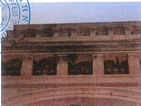
Εικ. 25. Αποθέσεις σωματιδιακών ρύπων σε προστατευμένες θέσεις.
