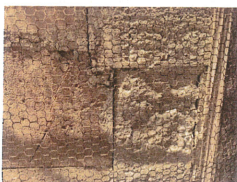
Εικ. 36. Προχωρημένη αποσάθρωση και υποχώρηση της επιφάνειας
