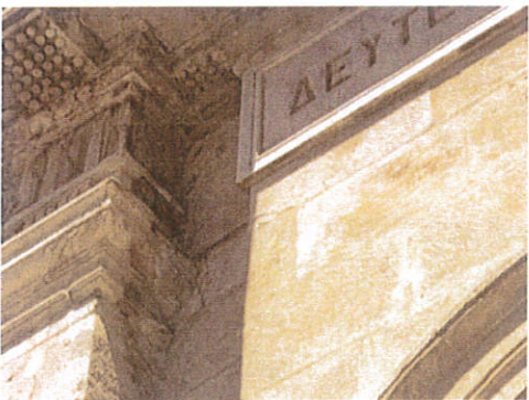
Εικ. 41. Θύρωμα: Αποθέσεις στους ασβεστόλιθους σε προστατευμένες θέσεις
