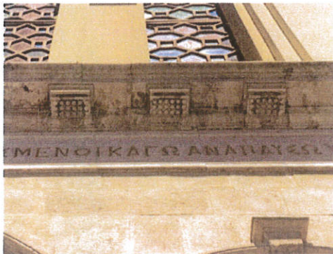
Εικ. 40. Θύρωμα: Αποθέσεις στους ασβεστόλιθους σε προστατευμένες θέσεις
