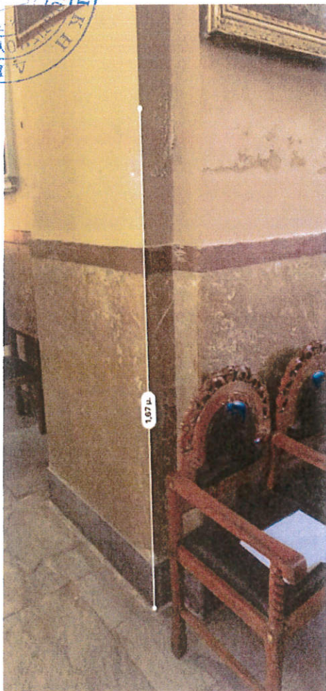
Εικ. 21. Το μέτωπο εξάτμισης της υγρασίας βρίσκεται σε ύψος περίπου 1.70 m από το δάπεδο
